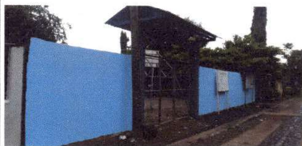
Foto 4: Pintura en muros exteriores en muro perimetral
