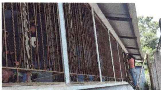
Foto 1: Mantenimiento a balcones de metal del módulo 1 parte de atrás
